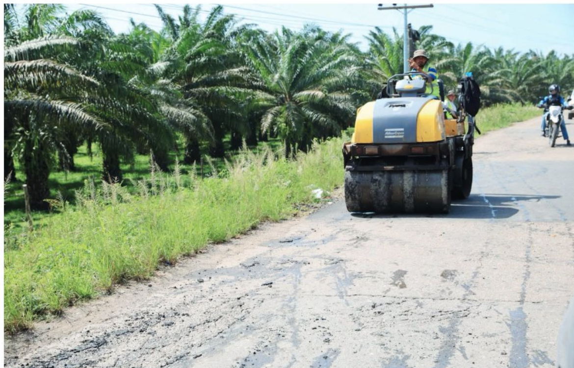
El impulso económico con la carretera catapultará la economía de la zona.
