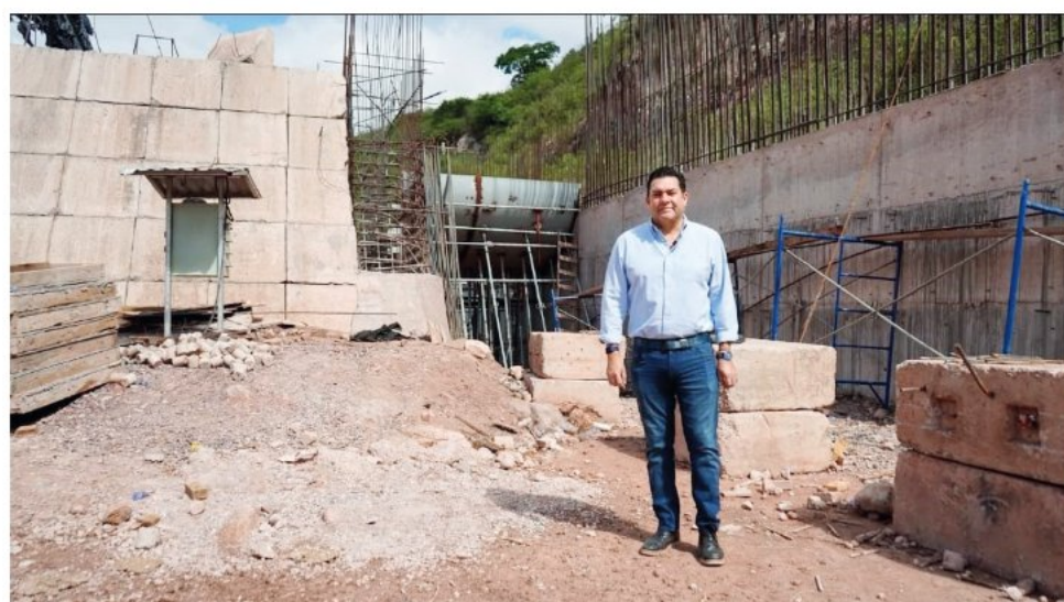
Los trabajos continúan de noche para entregar el proyecto en enero del 2028.
