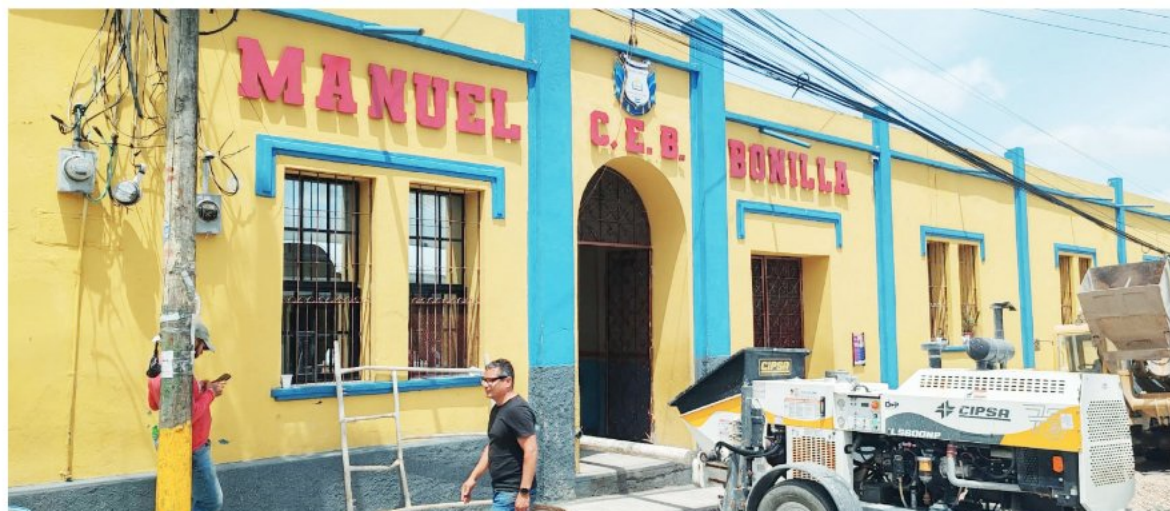
Los trabajos de restauración y ampliación se realizan dentro y fuera del centro educativo.
