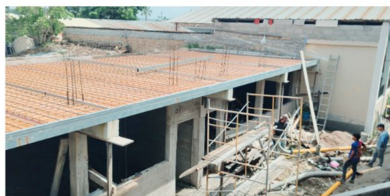
En lugar de un techo de láminas, se decidió realizar una losa de concreto.
