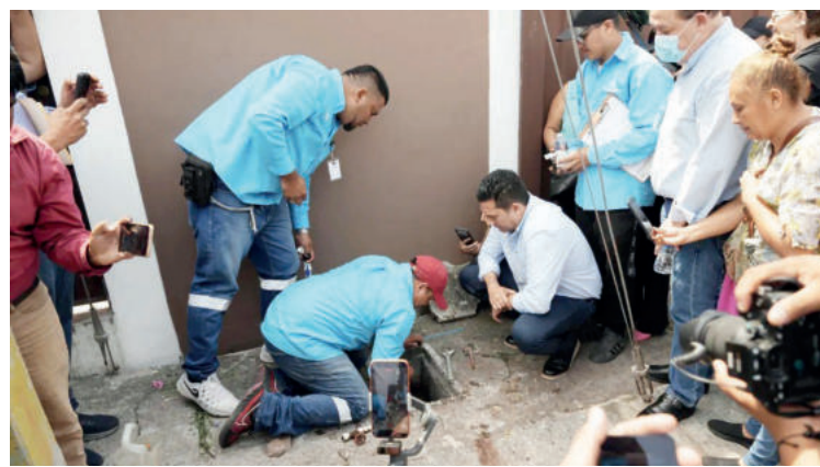
Durante el período más crítico del verano, la distribución descendió hasta aproximadamente 60,000 metros cúbicos diarios.
