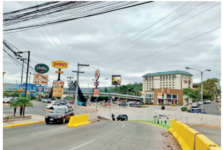
Con la señalización se busca hacer más visible la infraestructura vial y facilitar la circulación de conductores y peatones.
