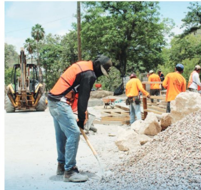
Hasta el momento se han instalado cuatro de los ocho tramos de vigas en la zona.
