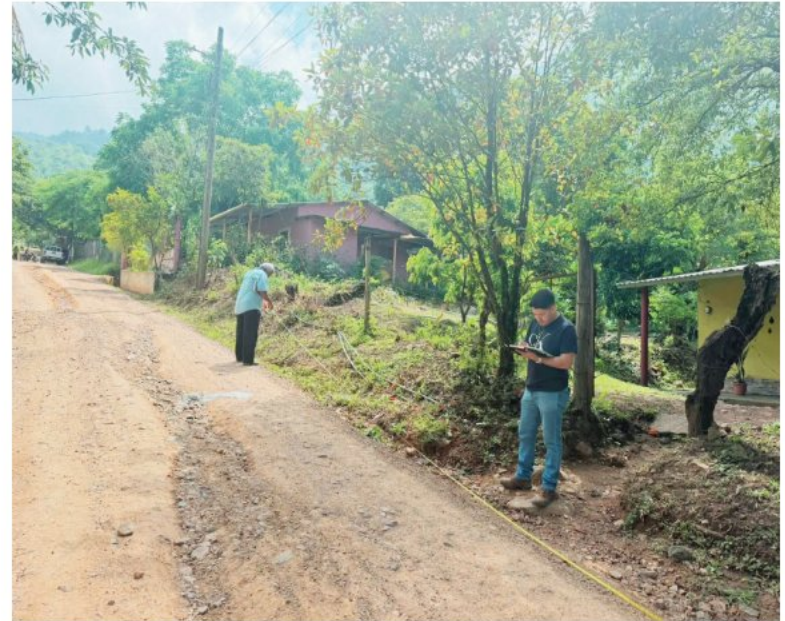
La ampliación de la red eléctrica en el sector de la Clínica Naturista beneficiará de manera directa a decenas de familias.
