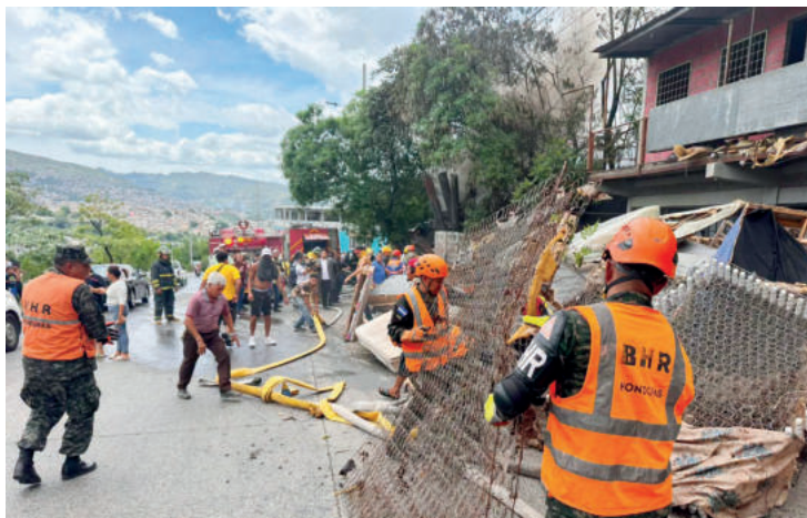
El personal militar ejecutó la remoción de materiales altamente inflamables.
