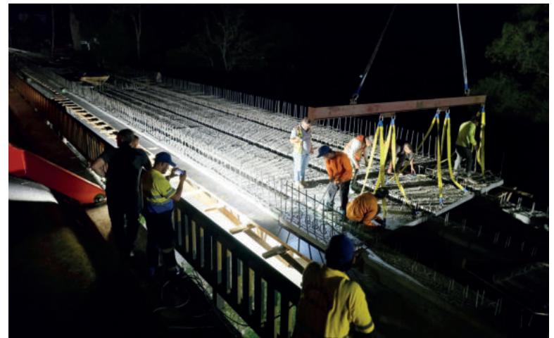
Personal de la SIT instala las prelosas en el puente de Germania, en el sur de Comayagüela.
