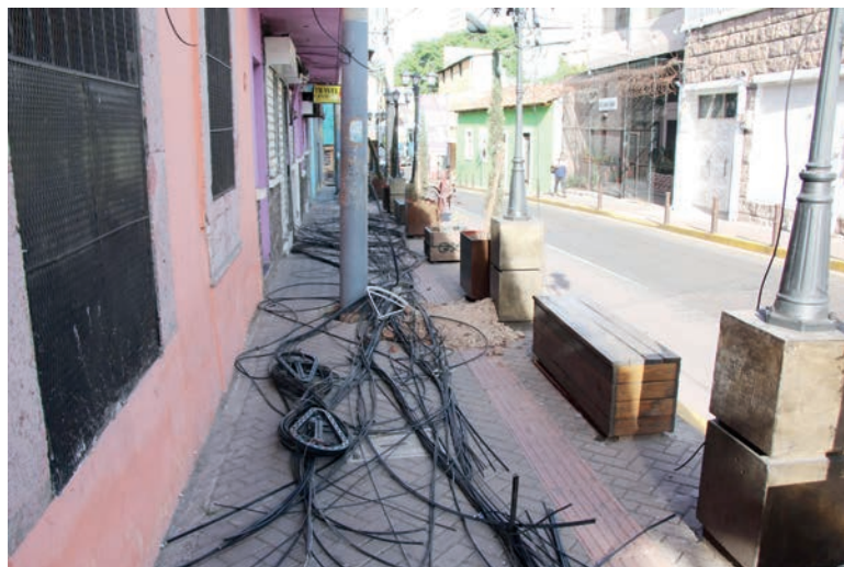
La eliminación del cableado inservible era indispensable para continuar con la pavimentación de la avenida Cervantes.
