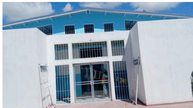
El edificio de la planta de procesamiento agroalimentario quedó a medias, sin equipo.
