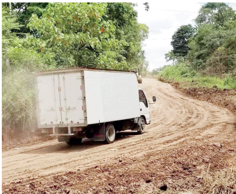
Las intervenciones contemplan nivelación, compactación y mejoramiento de la superficie.
