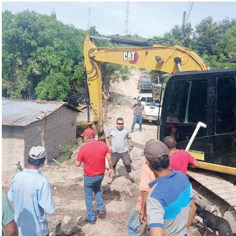
Los trabajos iniciaron en la calle principal y beneficiará a muchas familias.
