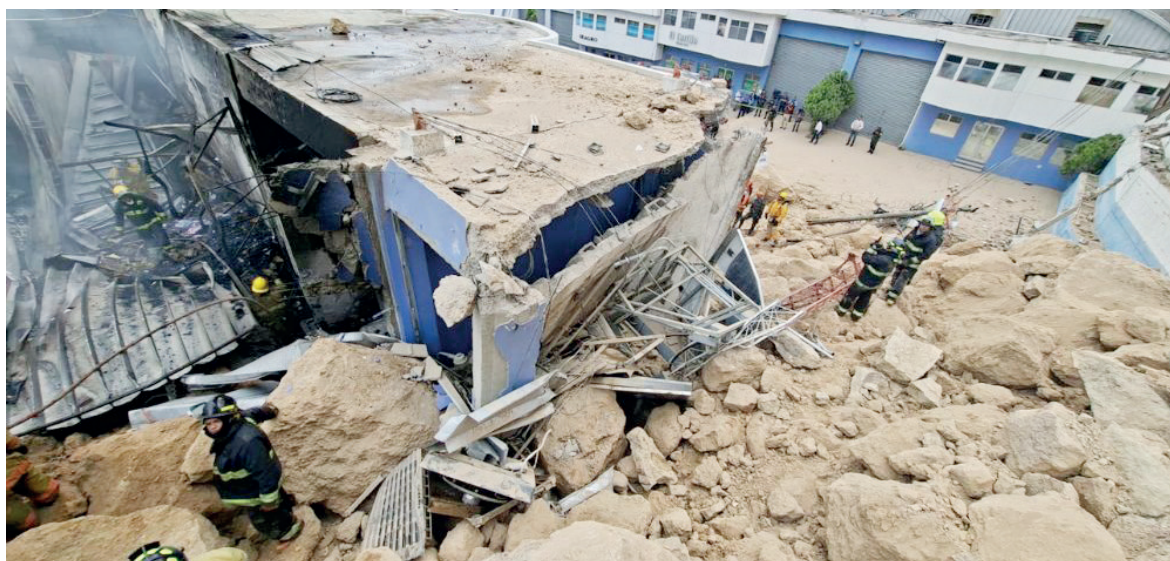
La alteración del terreno sin el respectivo permiso de construcción desató el derrumbe, según el análisis municipal.
