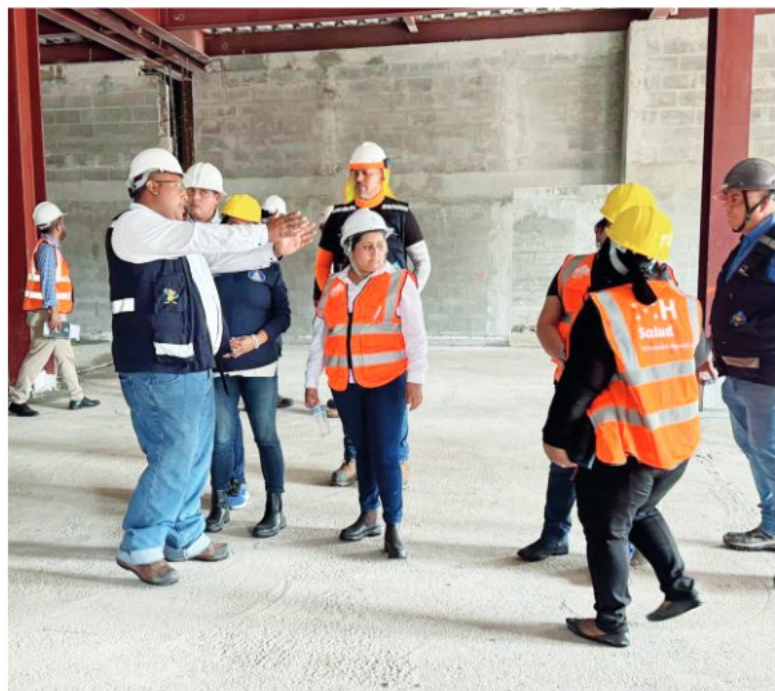
Los integrantes de la comisión recorrieron las instalaciones en construcción y constataron los avances físicos de la obra.
