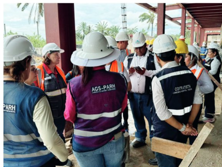
Se pretende garantizar la culminación y puesta en funcionamiento del nuevo hospital en el menor tiempo posible.
