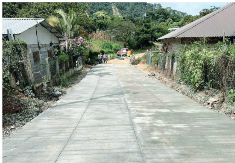
La alcaldía de La Unión trabaja actualmente en el reparación de varias calles del municipio.
