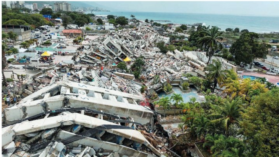
Unos 190 edificios fueron destruidos, otras 59,000 edificaciones sufrieron algún daño, siendo La Guaira y Caracas las zonas más afectadas.
