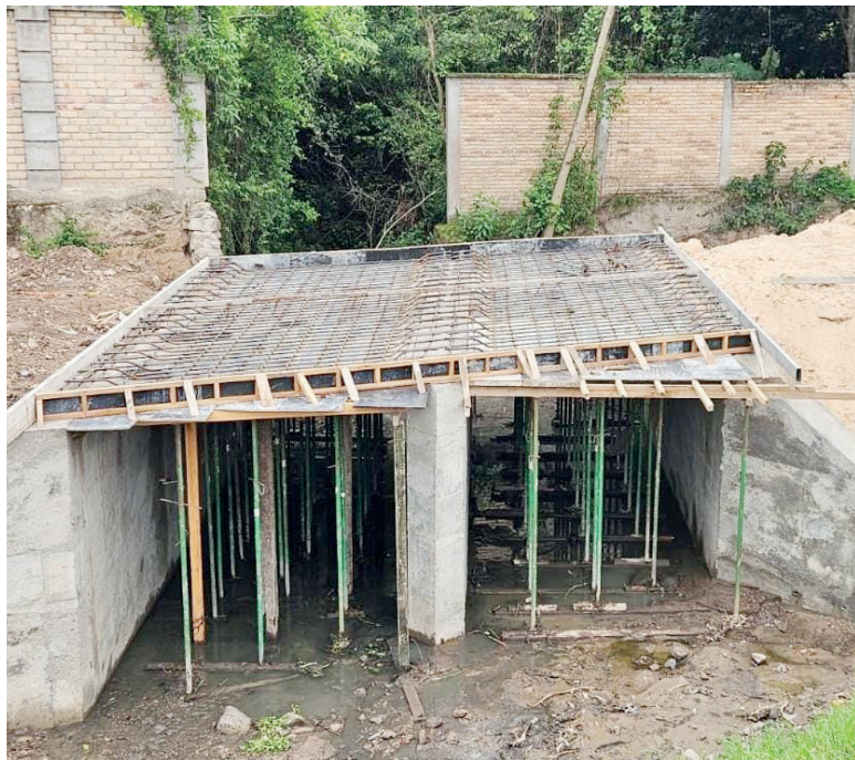
La obra permitirá optimizar el drenaje de aguas pluviales y mejorar la circulación vehicular.
