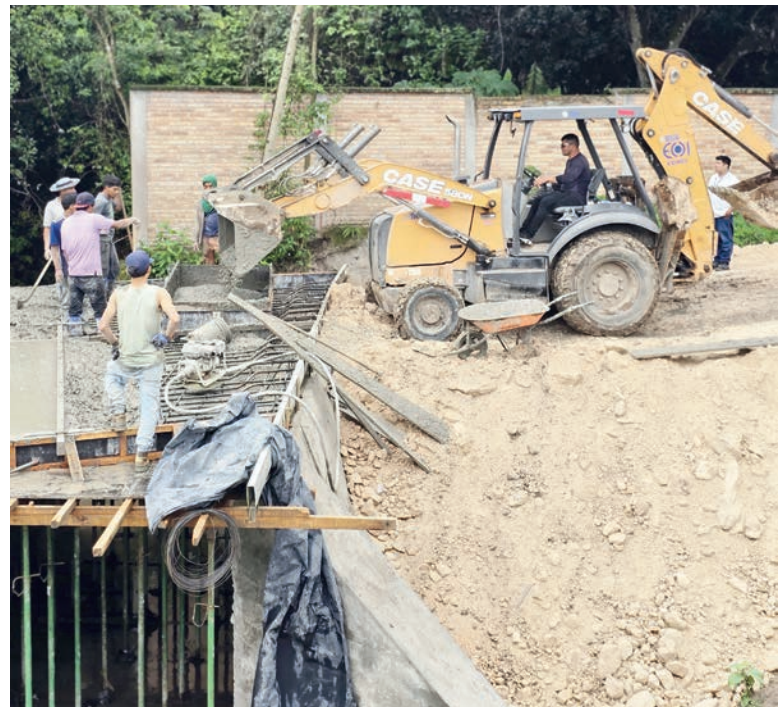
La obra es ejecutada por la empresa Constructora de Obras Civiles (ECOCI).
