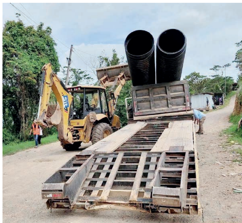
El objetivo de los trabajos de reparación es evitar que el aislamiento de las comunidades se prolongue.
