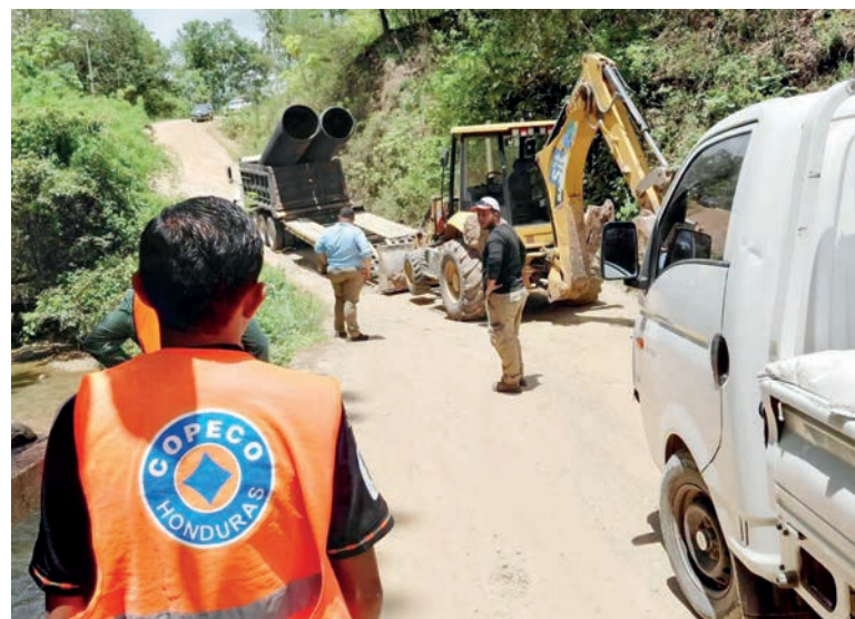
La rehabilitación del paso en El Mogote es considerada prioritaria debido a que esta vía conecta a Juticalpa con Patuca.
