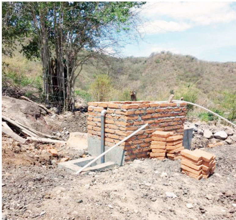
Se construyen dos pilas de distribución con capacidad de 25 mil galones.
