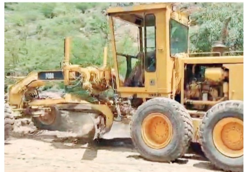
Una vez finalizado los trabajos en La Garza, se comenzarán en la aldea Guayabillas hasta El Arenal.
