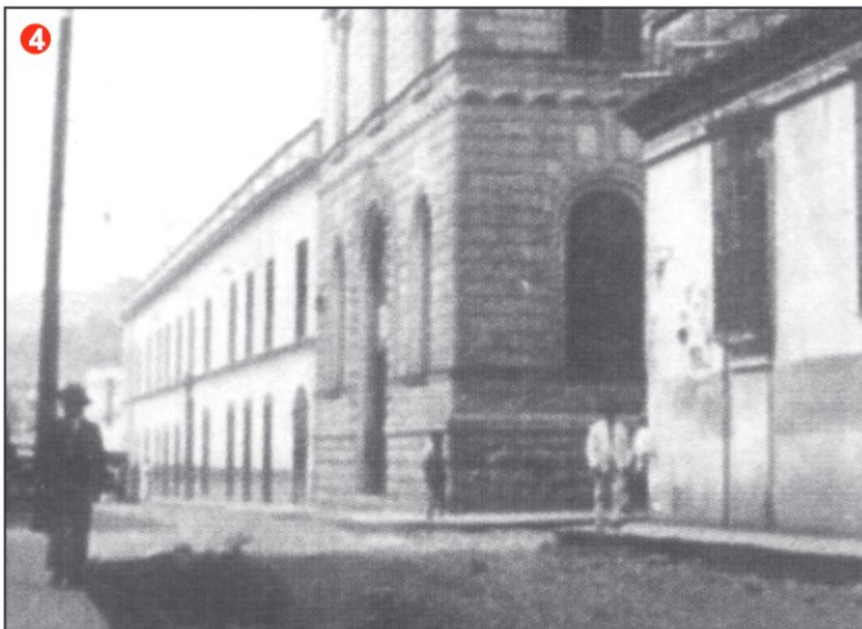
El antiguo edificio de dos plantas de la Policía Nacional destruido por un incendio en Julio de 1959
