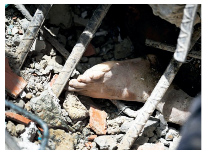
Un cuerpo yace atrapado bajo losas de hormigón derrumbadas mientras miembros de la Protección Civil de Venezuela buscan entre los escombros en el lugar de los edificios colapsados.
