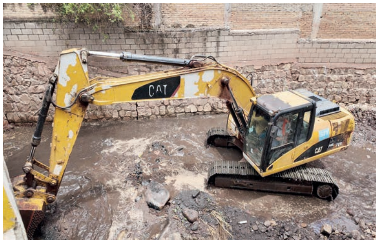
El Codem, realiza trabajos de limpieza, dragado y drenaje de quebradas en la capital, ante amenaza de nueva onda tropical.
