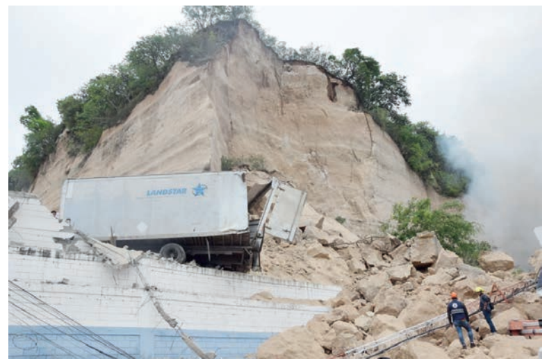
Según testigos el cerro ya había avisado semanas atrás con leves desprendimientos de piedras.
