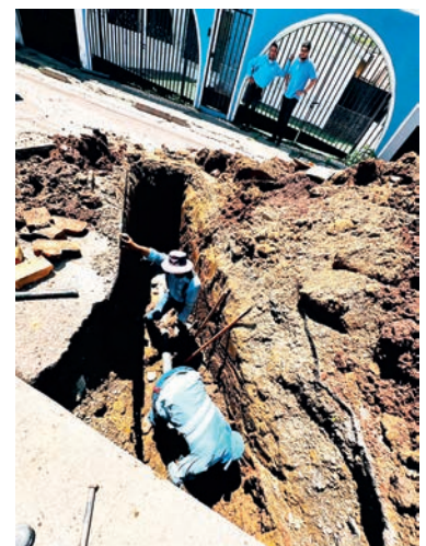
La labor de limpieza de las alcantarillas fue ardua en distintos puntos de la capital.
