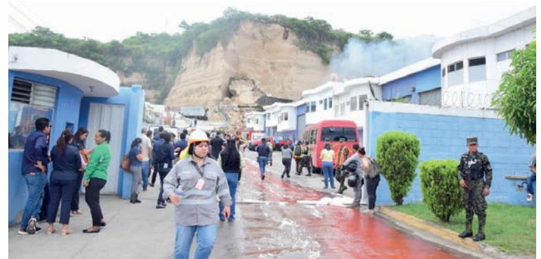
Momentos de terror se vivieron durante el derrumbe seguido de un incendio estructural.
