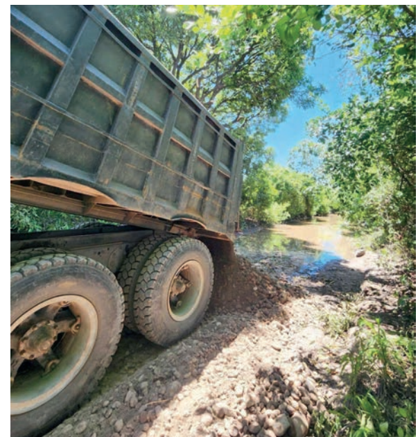
Los trabajos incluyen un relleno, en una zona donde atraviesa una quebrada.
