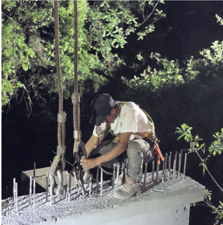
De manera simultánea, los equipos técnicos de la SIT ejecutan trabajos de colocación de refuerzo en los diafragmas de la estructura.
