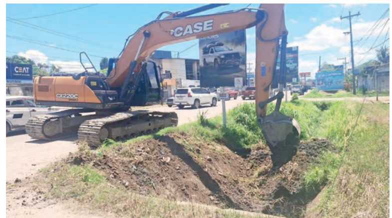
Los trabajos son ejecutados por el equipo técnico de Infraestructura de la Municipalidad de Tocoa.
