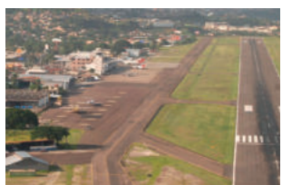
Advierten accidentes ante el deterioro de la pista aérea.
