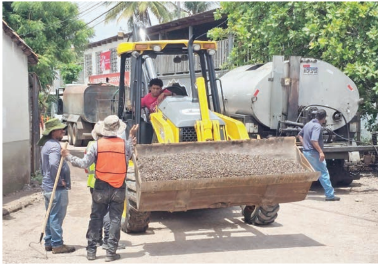
La obra está en su etapa de preparación antes de comenzar los trabajos de pavimentación.
