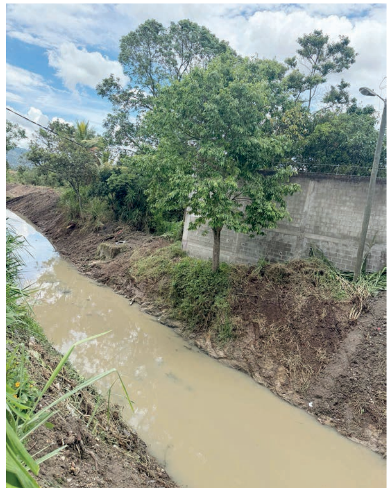
Las labores consisten en la limpieza y remoción de sedimentos acumulados en el cauce de los ríos.
