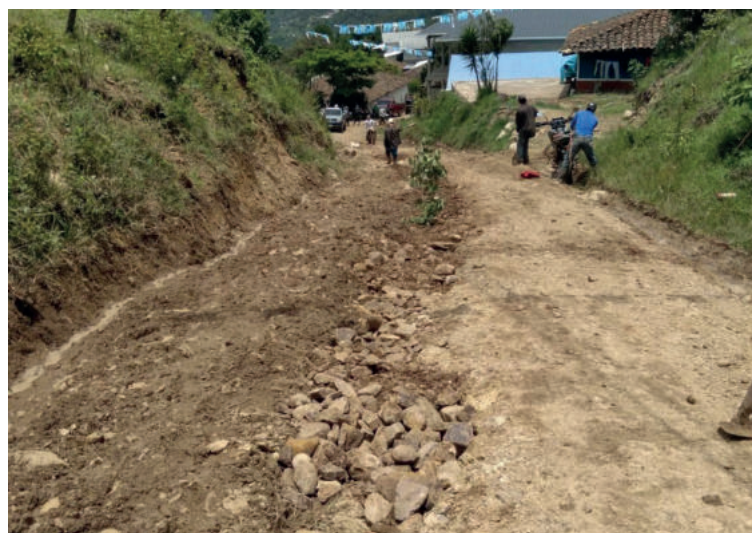
Aquí hicieron la cuneta de la carretera, para que el agua no lavara la carretera de tierra.
