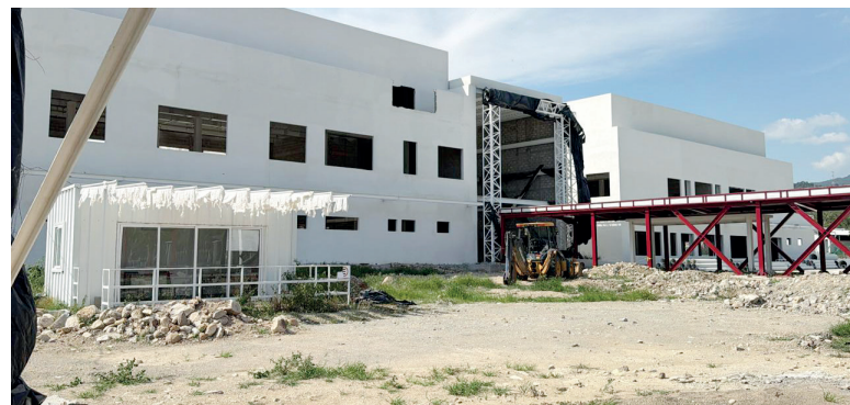
La obra gris del inmueble está avanzada en una buena parte, pero falta mucho.
