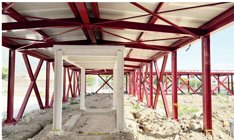
La población exige que las columnas abandonadas dejen de ser un símbolo de desidia.
