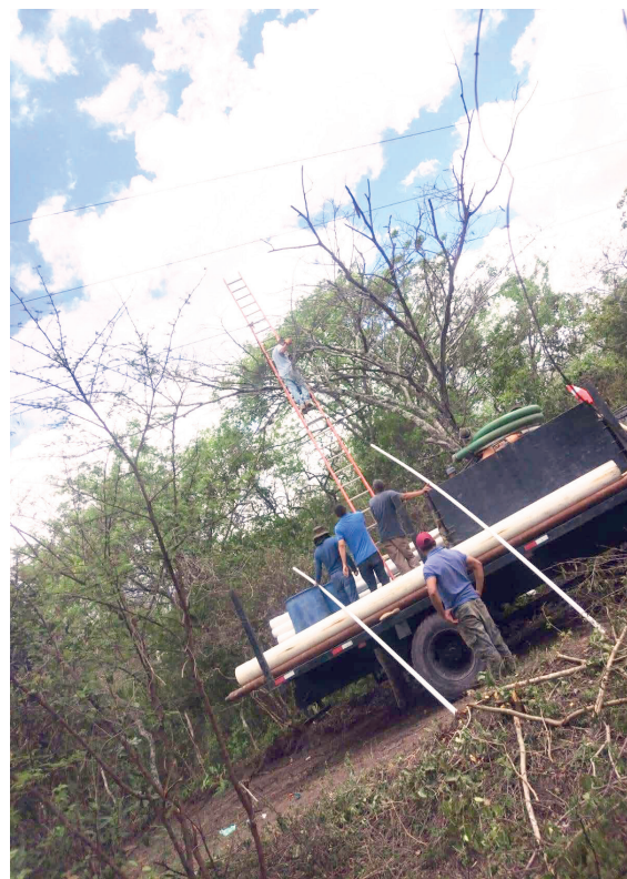
Los trabajos de perforación avanzan conforme al cronograma establecido por la alcaldía.
