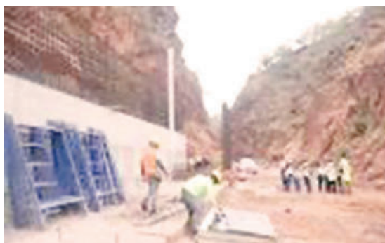
La represa San José tiene un avance del 43 por ciento y vendrá a mitigar la problemática de agua en la capital.
