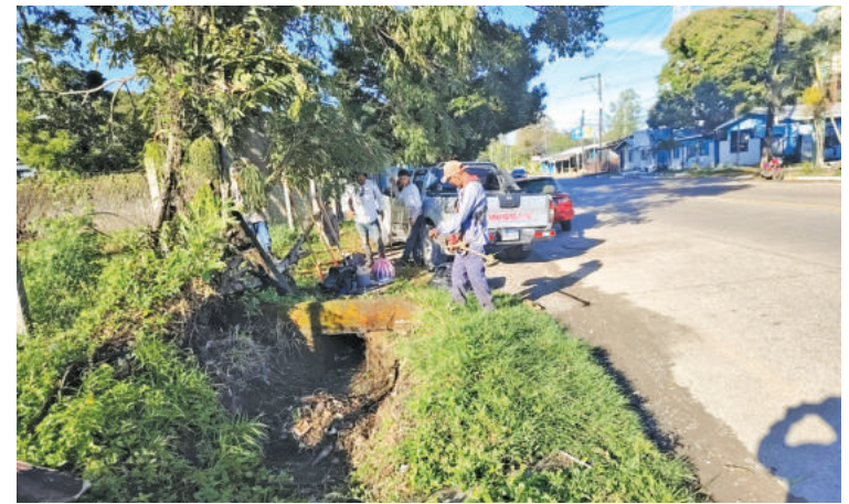
Se limpiaron los canales de aguas lluvias de varias colonias.
