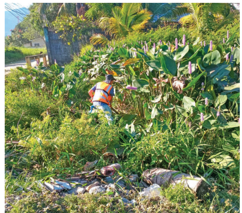
Las labores buscan prevenir daños a viviendas y calles.
