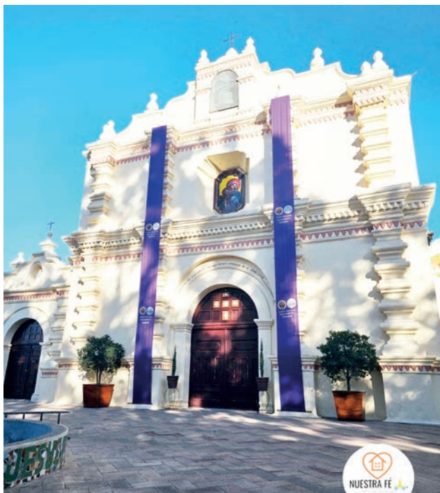
El templo colonial, construido entre 1807 y 1809 y recientemente restaurado.
