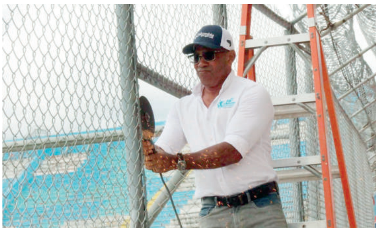
El comisionado de Deporte, Mario Moncada, inició con la remoción del cerco de sol centro.
