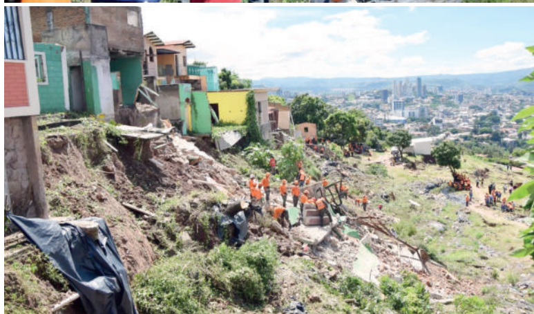
La “Zona Cero” ha sido considerada de alto riesgo y de vulnerabilidad extrema por la saturación de suelos.
